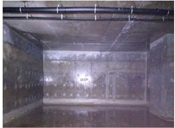
รูปภาพที่ 28 ล้างถังสำรองน้ำใต้ดิน/ชั้นดาดฟ้า
