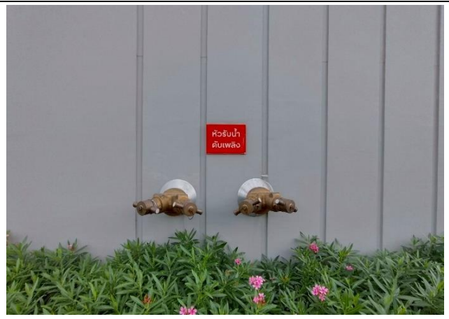
รูปภาพที่ 9 หัวรับน้ำดับเพลิง
